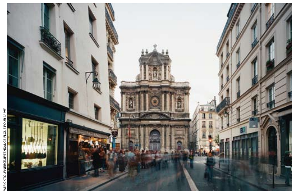
Un des grands travaux programmés : restaurer la façade de Saint-Paul-Saint-Louis.
